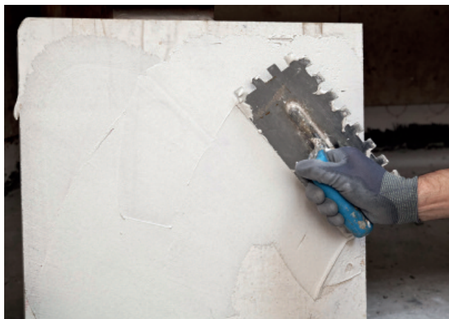
W celu zapewnienia niemal pełnego podklejenia zaleca się nakładanie zaprawy także na spodnią stronę płytki.
