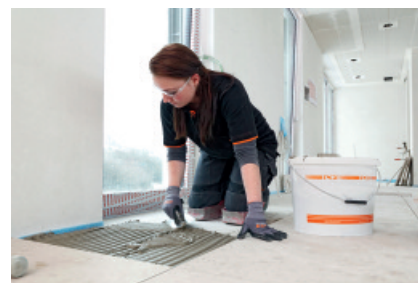
PCI Carrament ® weiß umożliwia bezpieczne wyklejanie okładzin z kamienia naturalnego metodą średniowarstwową.
