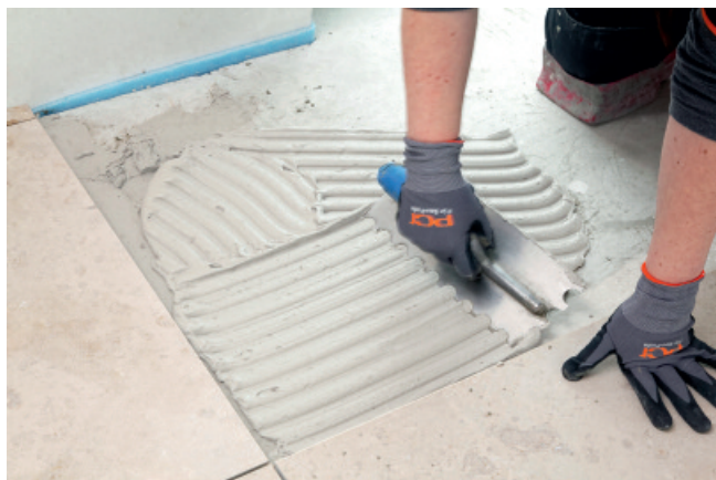
PCI Carrament® weiß posiada plastyczną konsystencję pozwalającą na wygodne stosowanie w wersji zaprawy średniowarstwowej.
